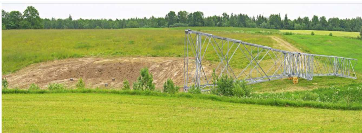
5.2 pav. Statybos aikštelė su nuimtu dirvožemio sluoksniu (R. Milerio nuotrauka, statoma OL Klaipėda – Telšiai).
